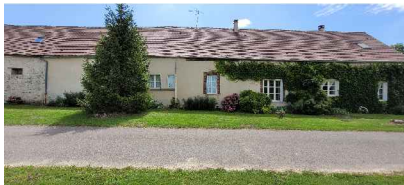
Bâtiment A façade nord
