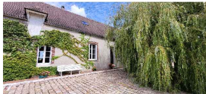
Bâtiment A façade sud
