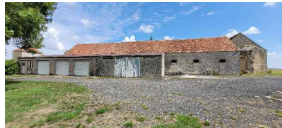
Bâtiment D façade ouest
