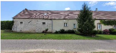
Bâtiment A façade nord
