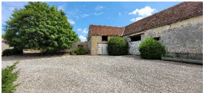
Bâtiment C façade ouest
