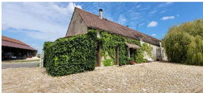
Bâtiment A façade sud
