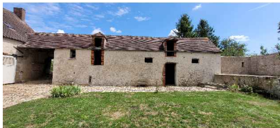
Bâtiment B façade ouest
