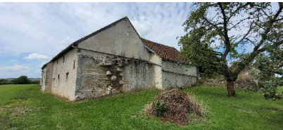
Bâtiment C façade est
