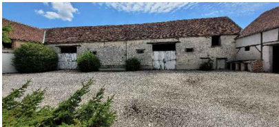
Bâtiment C façade nord
