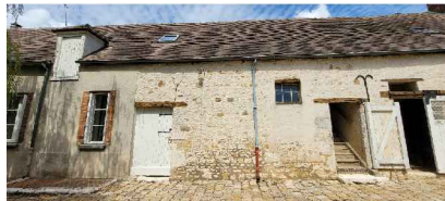
Bâtiment A façade sud
