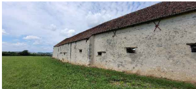
Bâtiment C façade sud
