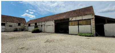
Bâtiment D façade est
